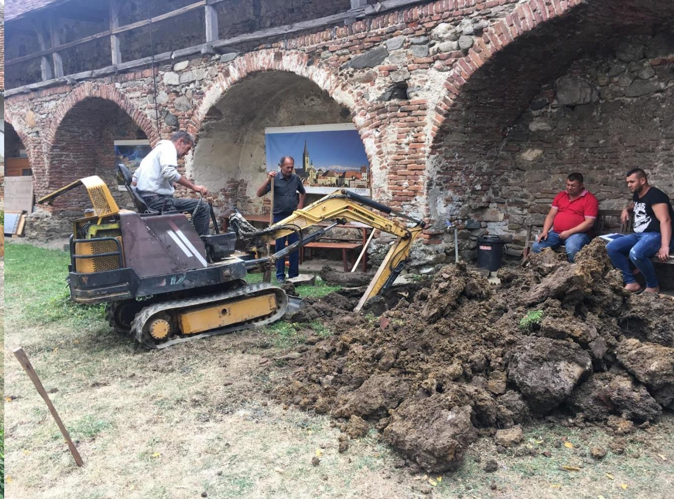
Ein Wasserschacht für die neue Wasserleitung wird gegraben. Einer arbeitet, drei schauen zu....
